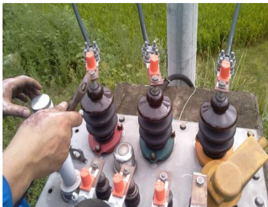
图 户外变压器测温现场安装图
